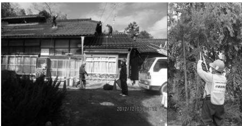
1. ábra. Lakóház és kert dekontaminációja bal oldalon tetőmosás nagynyomású vízzel, jobb oldalon fa levágása
