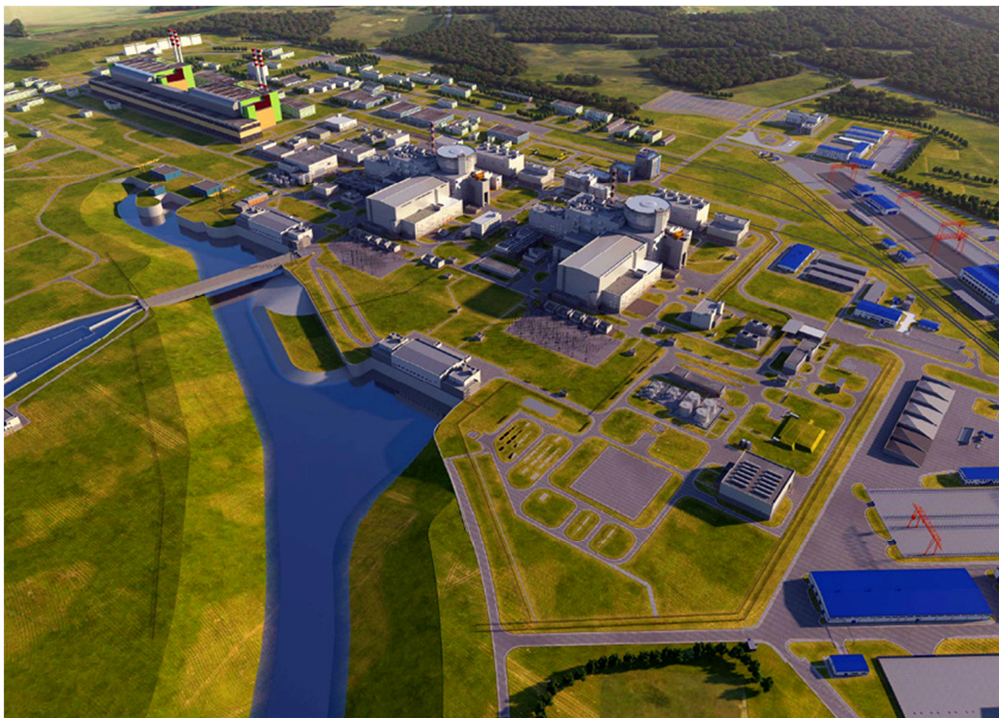
2. ábra. Paks II. madártávlatból. Előtérben a hidegvíz-csatorna és Paks II. vízkivételi műve. A hidegvíz-csatorna felett hídon vezetik át Paks II. melegvíz-csatornáját. (Forrás: paks2.hu)
